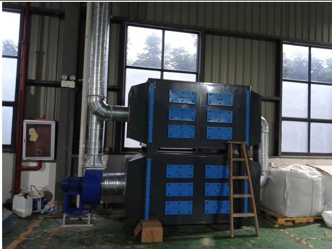
图 3-2 废气处理设施图
