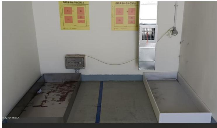
图 3-4 危废间储漏托盘
