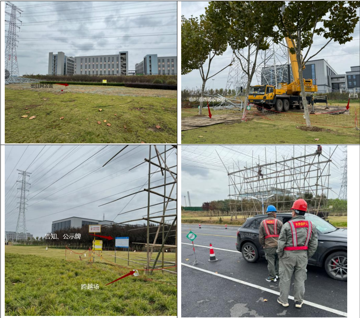
图6-1 本项目施工期环境保护措施照片
