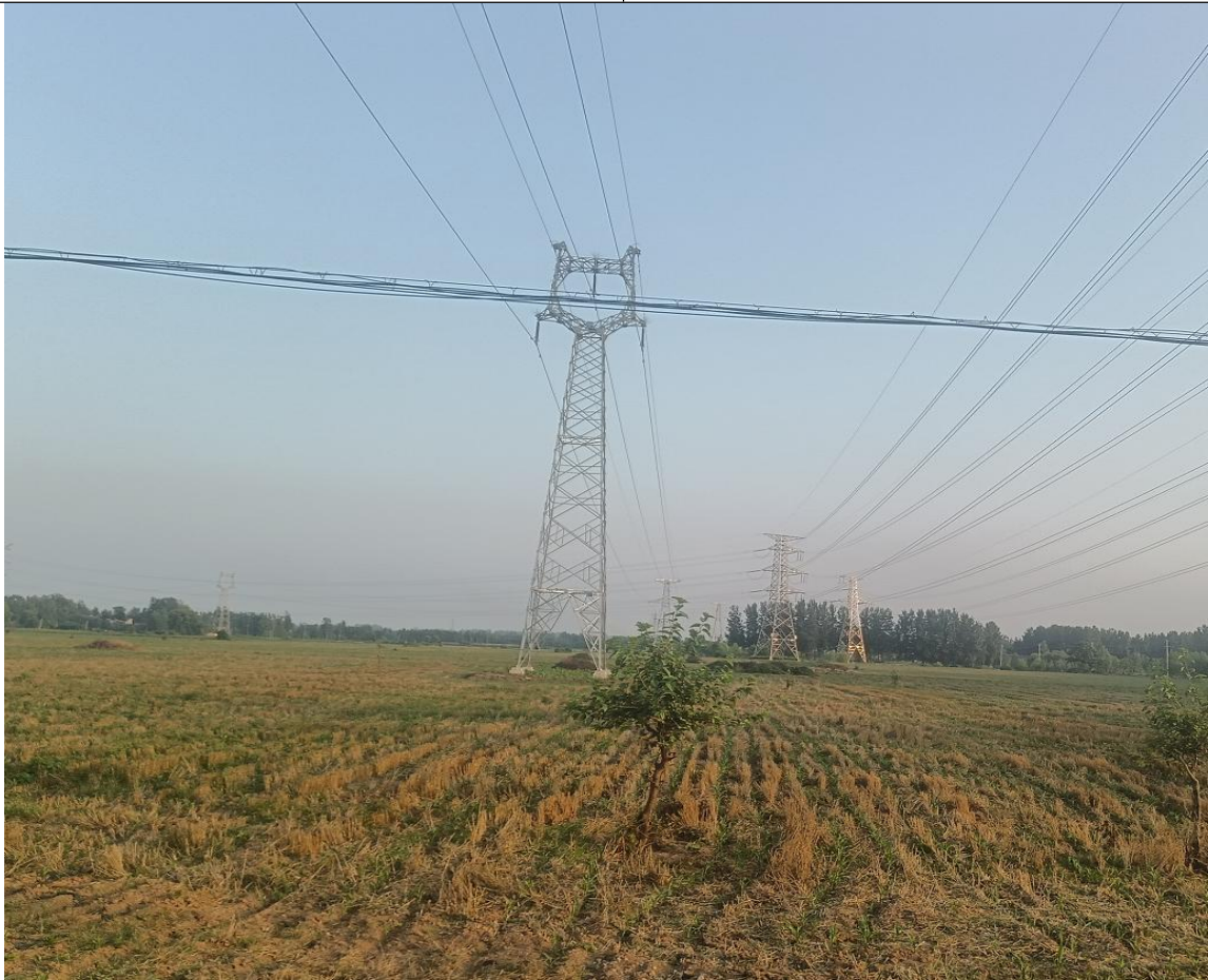
本工程交叉跨越状况 图6-3 本工程现状照片
