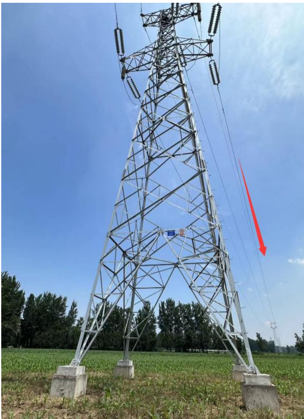
图6-2 本工程线路航拍图（1）
