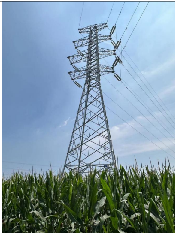
角钢塔（转角塔）塔基复垦
