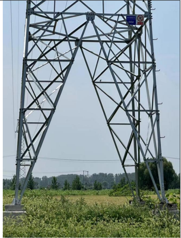
角钢塔塔基复垦
