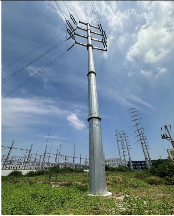
钢管杆塔（转角塔）基复绿情况
