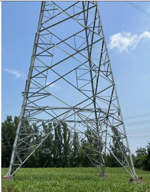
角钢塔塔基复垦
